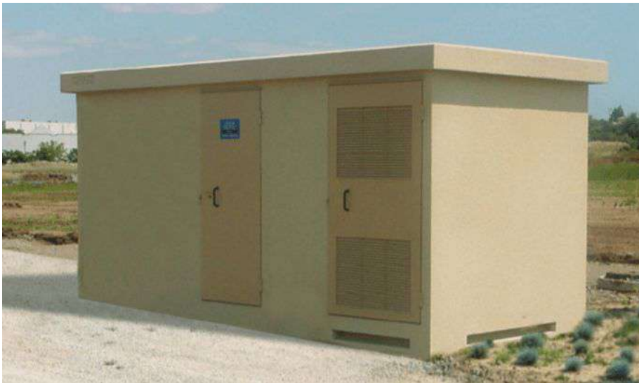
Poste de transformation HTA/BT
